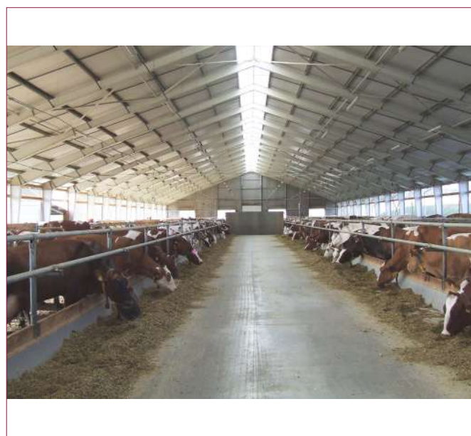
Obr. 52. Tepelná izolace stropně-střešního pláště stáje omezuje prostup tepla do stáje v průběhu horkého léta
