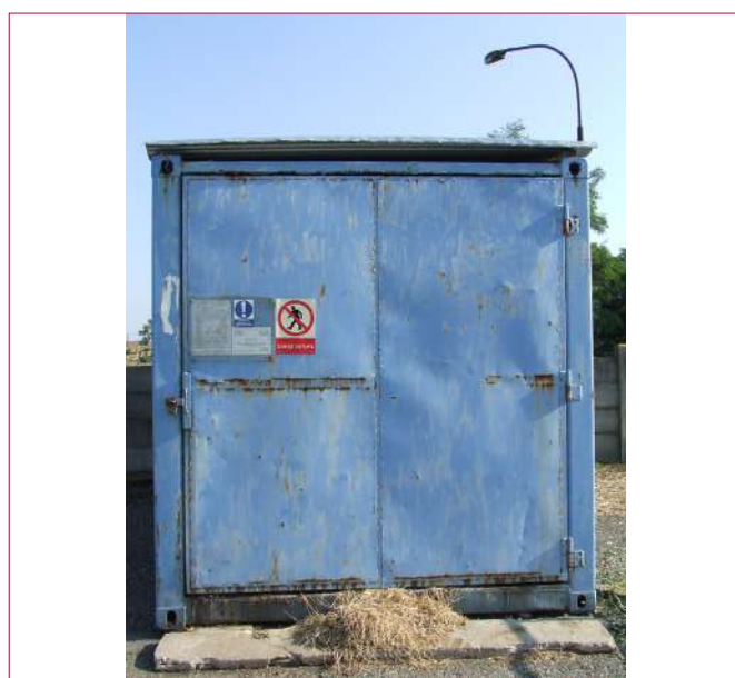
Obr. 82. Kafilerní box musí být zabezpečen proti vniknutí
