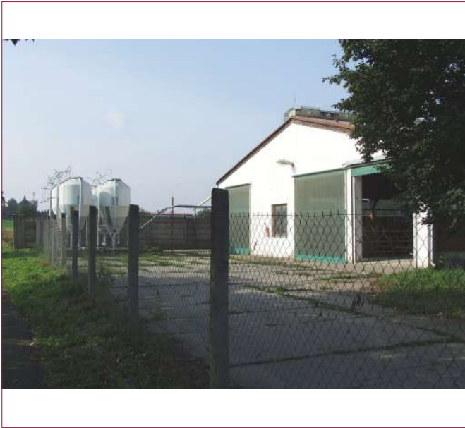
Obr. 6. Neporušené oplocení brání průniku volně žijících zvířat a nepovolaných osob na farmu
