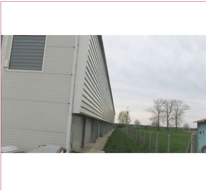
Obr. 57. Betonové pásy okolo stáje omezují riziko průniku hlodavců do stájí
