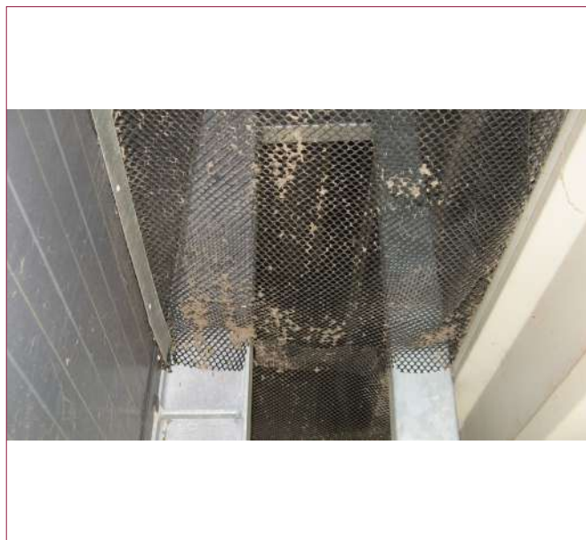
Obr. 64. Sítě na vstupních otvorech pro přívod vzduchu do haly brání průniku ptáků
