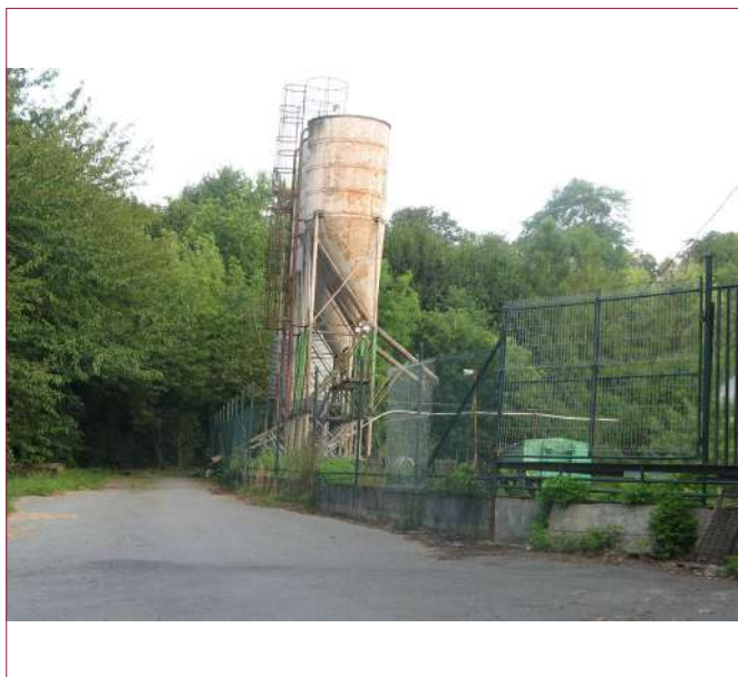
Obr. 27. Sila na krmné směsi se plní z obslužné komunikace
