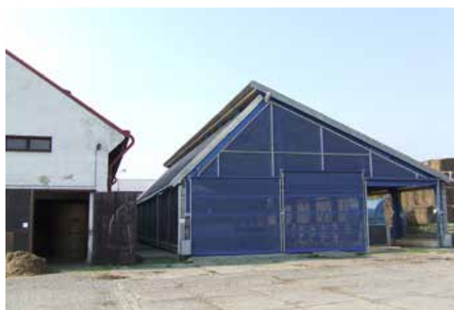
Obr. 47. Při malé vzdálenosti mezi jednotlivými stájemi dochází k vzájemnému nasávání vzduchu mezi stájemi
