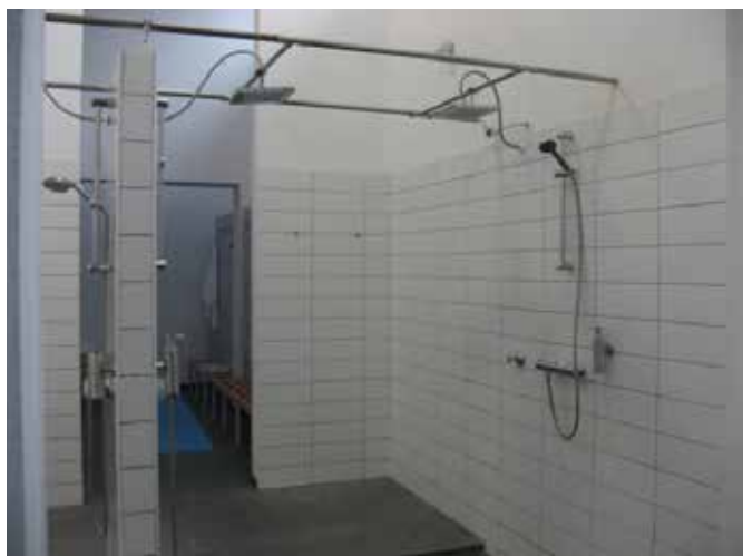
Obr. 14. Průchozí sprchy z nečisté do čisté šatny
