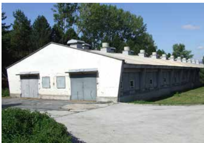
Obr. 8. Uzamčení objektu účinně zamezuje kontaktu cizích osob se zvířaty
