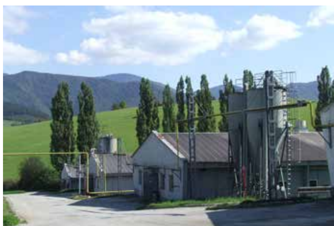
Obr. 46. Dostatečná vzdálenosti mezi jednotlivými stájemi brání vzájemnému nasávání vzduchu mezi stájemi
