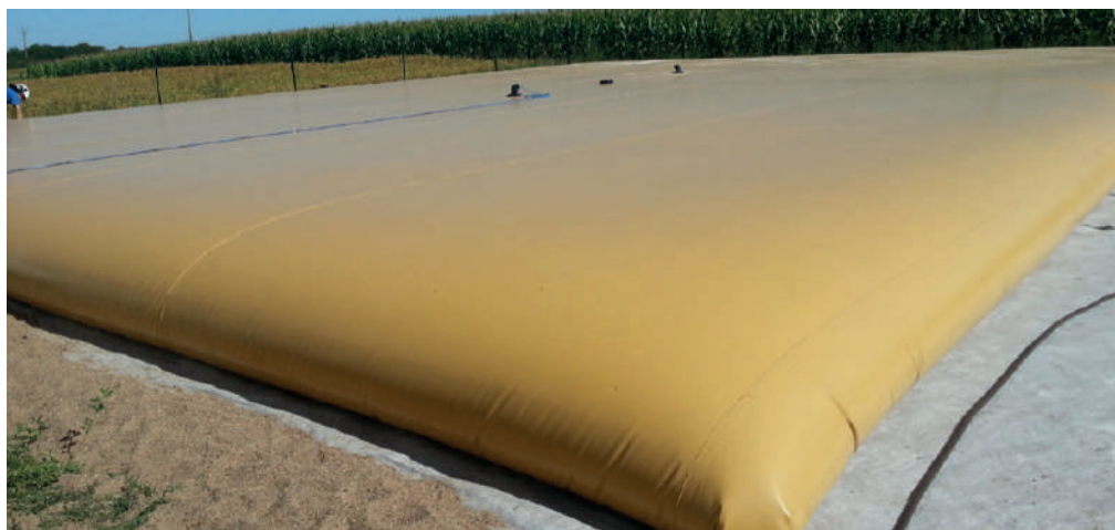
Obr. 2: Flexibilní nádrž se zásobou dešťové vody
