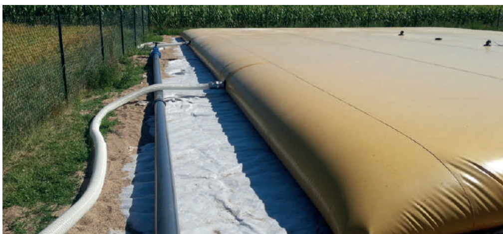
Obr. 3: Flexibilní nádrž se zásobou dešťové vody
